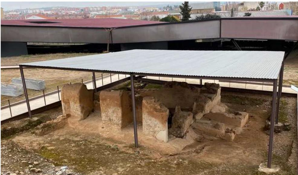
Se ha contemplado la ampliación de la zona trasera de la estructura que soporta la cubierta, sin repercutir en el tránsito actual o en la zona arqueológica, trabajando únicamente con elementos aéreos sin ninguna necesidad de excavación arqueológica. Los elementos insertados han ampliado y reforzado la estructura inicial, a través de la unión transversal en un extremo, que ha fomentado su consistencia y rigidez.
