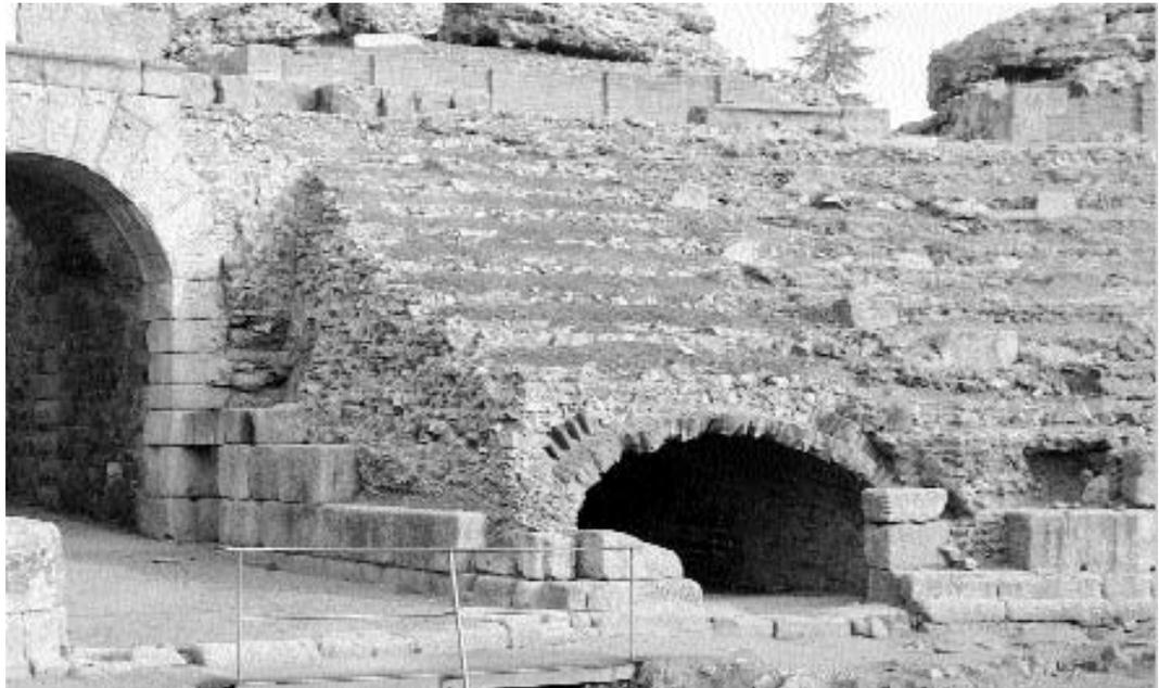
En esta imagen se observa parte de la grada, muy deteriorada. El acceso era posible gracias a la existencia de 16 portadas en la fachada, de las cuales partían los vomitorios. Estas galerías conducían a su vez a unas escaleras, que compartimentaban en sectores el espacio destinado a asientos.
