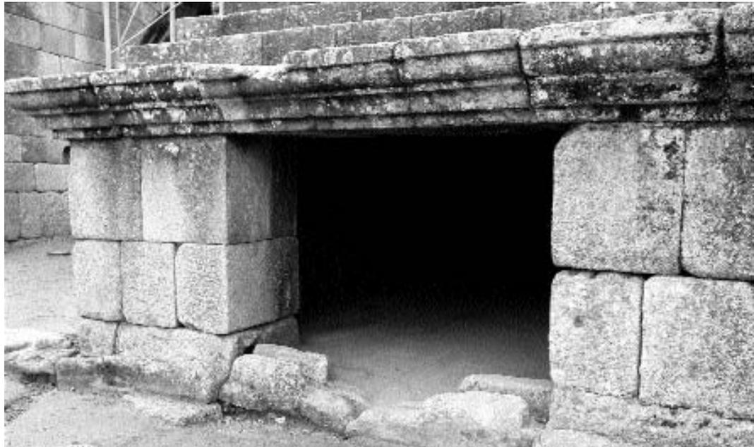
Esta imagen pertenece a otra de las habitaciones laterales dispuestas a los lados de otro de los accesos monumentales a la arena. En este caso se observa el recubrimiento del grueso de obra mediante sillares de granito, así como el remate moldurado del podio. Sobre este remate se ubicaría una balaustrada con decoración pictórica, al parecer perteneciente a una reforma del edificio. Se ofrece más información sobre este aspecto en la diapositiva 6.
