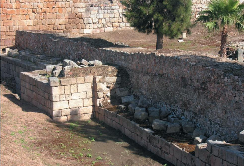
**Fig. 2.** Las defensas de Mérida se basaban en una doble muralla heredada desde la época romana (con muro de mampostería) y visigoda (con muro de sillares antepuestos).
