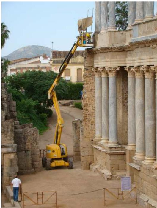
La actuación ha consistido en la reparación de enfoscados deteriorados en el frente escénico, concretamente en la zona del podio del segundo cuerpo de columnas, a 10 metros de altura y con una extensión de 52 metros de longitud.
