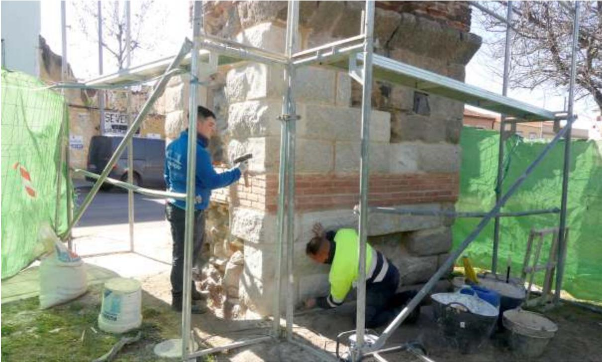
Detalle del proceso de labrado (abujardado) del granito para confeccionar la superficie rugosa.
