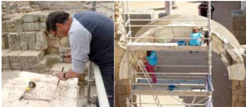
Detalle de la sustitución de los viejos anclajes de las placas de mármol por otros de acero inoxidable.
