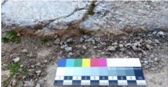
Detalle del deterioro de los bordes del mármol a finales del 2021.
