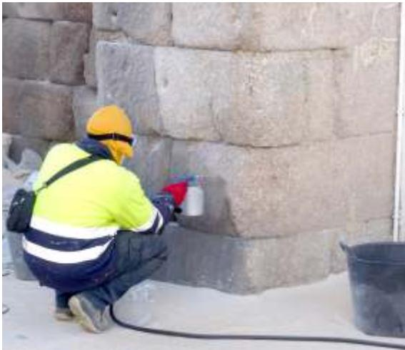
Proceso de limpieza con microabrasímetro en la parte inferior y más sucia del Arco.
