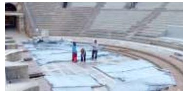
Proceso de aplicación del bioconsolidante Myxostone M3P © mediante pulverizado directo sobre la piedra original.
