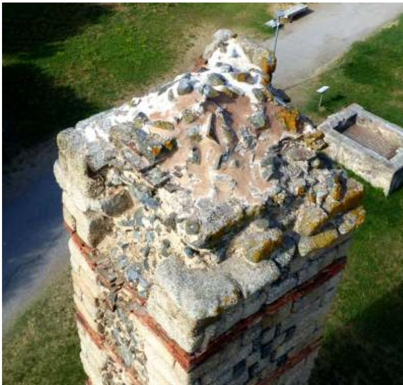
Proceso de sellado de las piedras con mortero de cal natural entonado para la consolidación de las coronaciones.
