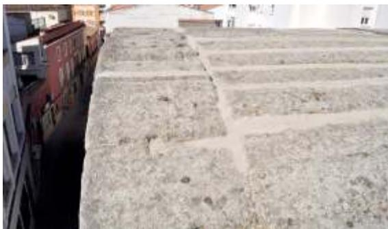
Detalle del sellado de las juntas con mortero natural para evitar filtraciones en la parte superior.
