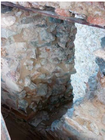
Situación del hueco de acceso a la terraza del podio del segundo orden.
