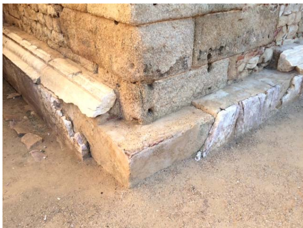
Fig. 1 Restos de los anclajes de hierro para el emplacado de mármol en el podio del teatro. En la imagen central se puede observar el daño que ocasiona la oxidación de estos elementos.
