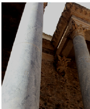
Fig. 4 Columnas de restitución marcadas
