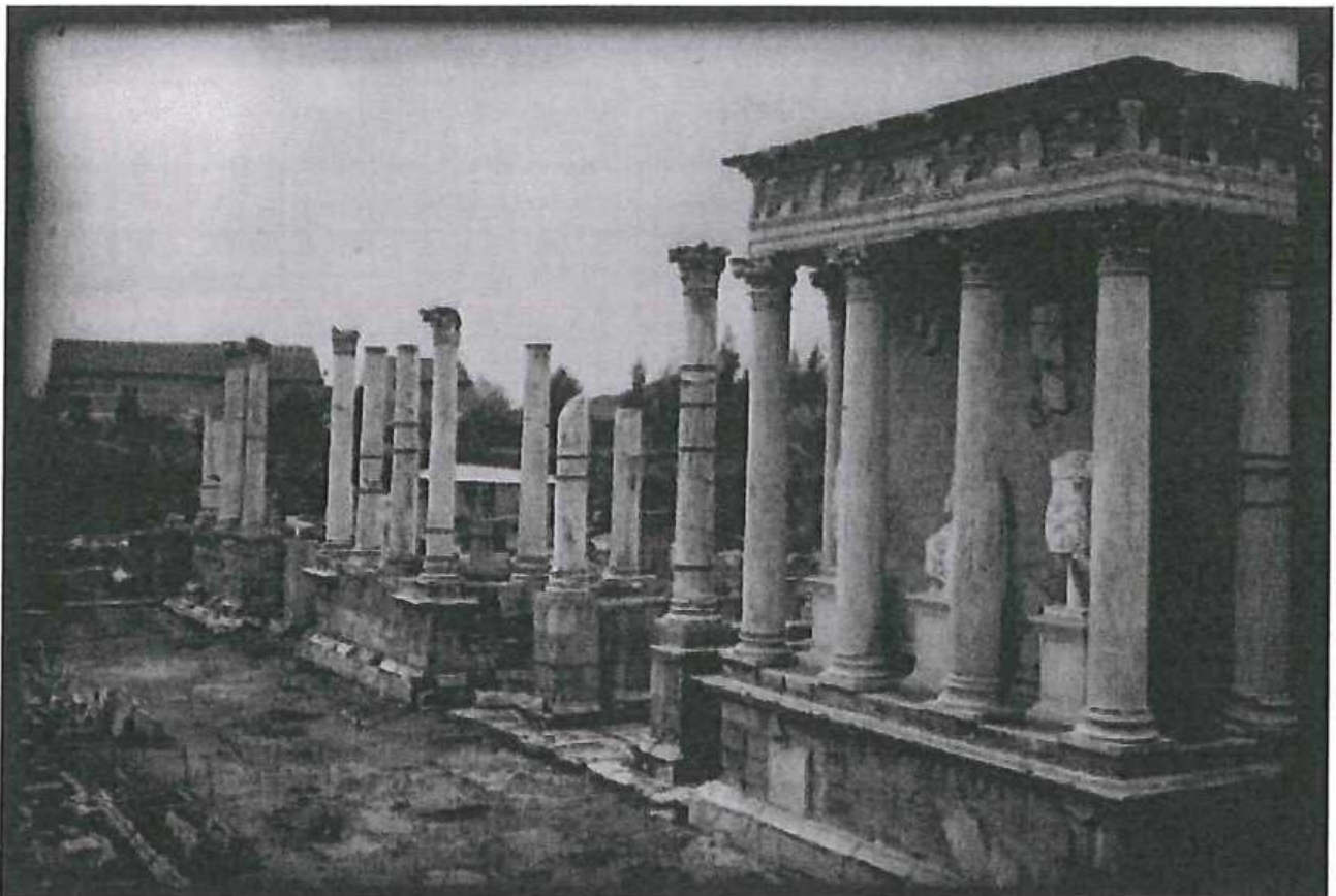
Fig. 2 Obras de restauración del primer orden (Fuente: Archivo Loty - 07600 del IPCE)
