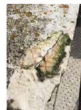
Retirada de mortero en mal estado, grapas metálicas.
