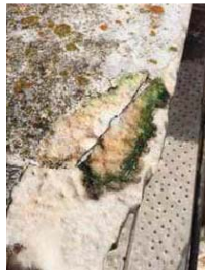
Fig. 1 Ejemplo de contaminación biológica en los mármoles y morteros de la intervención del 96, reparados en la Fase II
