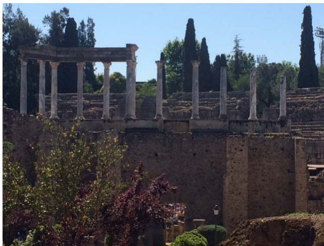
Fig. 6 Ennegrecimiento de los morteros de reintegración por la proliferación de microorganismos y deposición de partículas de suciedad (Sector B.1.IV)
