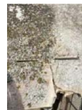
Retirada de mortero en mal estado, grapas metálicas.
