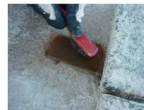
Eliminación de óxido con cepillo metálico.
