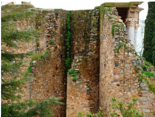
Fig. 4 Diversidad de elementos con contaminación de musgos, líquenes y plantas de bajo porte de todo tipo.
