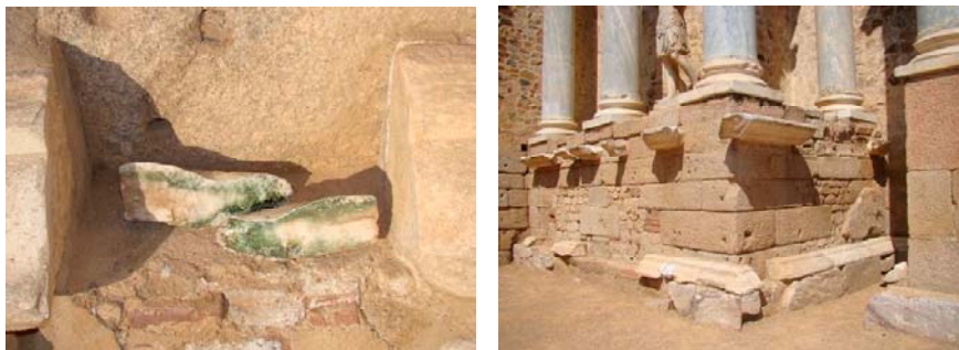
Fig. 7 Retirada de fragmentos con riesgo de desprendimiento y recolocación in situ
