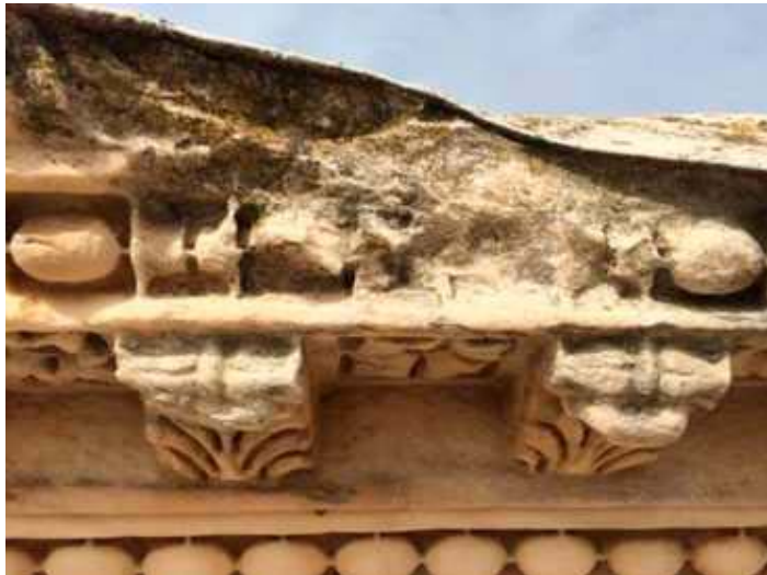
Fig. 5 Proliferación de microorganismos sobre superficies de mármol.
