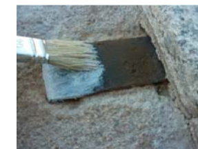
Aplicación de pasivante/ Compuesto ácido tánico + Benzotriazol.
