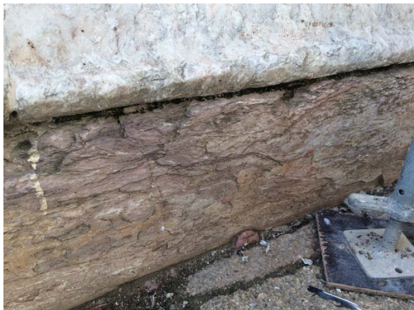
Fig. 10 Exfoliación superficial en las placas de revestimiento marmóreo del podio en el frente escénico (Sector A.3.II).
