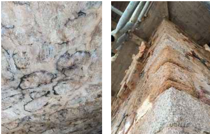
Fig. 3 Eflorescencias salinas en diversos puntos muro de mampostería del postcaenium .
