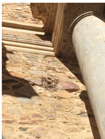
Fig. 8 Avispero en muro de mampostería postcaenium .
