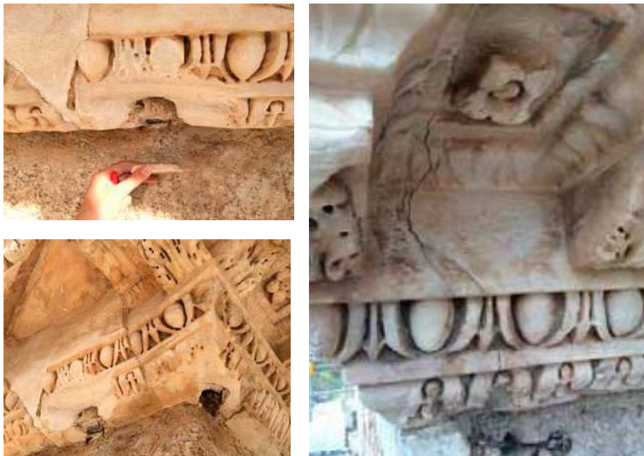
Fig. 9 Diversas fracturas en distintas cornisas del orden superior por efecto de la oxidación de las grapas de hierro utilizadas como sistema de fijación al plinto.
