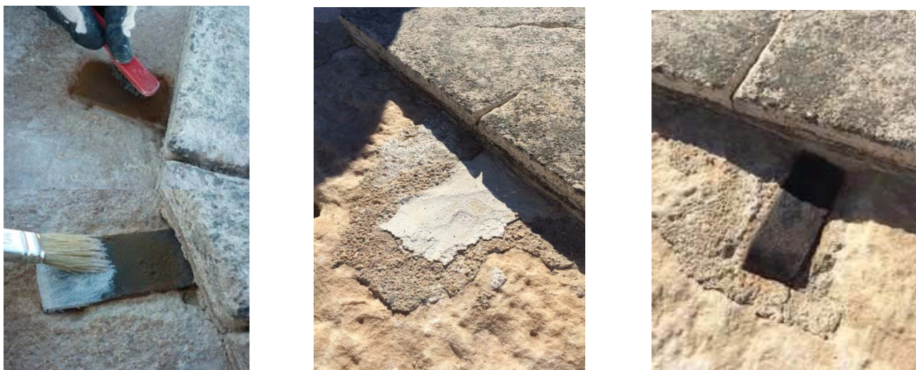
Ejemplo de anclaje metálico (acero con alto contenido en carbono) tratado en Fase II.
