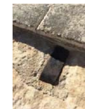
Situación final del anclaje.
