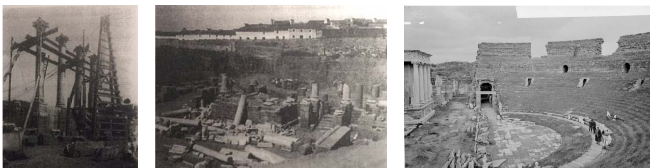
Fig. 3 Estado de la escena tras las excavaciones (1916) (izda.) y primeras obras de restitución de elementos constructivos de la escena (1921) (centro.) (Fuente: BARROSO MARTÍNEZ; MORGADO PORTERO, 2010). Graderío (dcha.) (Fuente: Antonio Passaporte 1927-1936 Archivo: IPCE).
