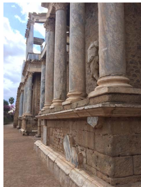
Fig. 1 Restos de los anclajes de hierro para el emplacado de mármol en el podio del teatro. En la imagen central se puede observar el daño que ocasiona la oxidación de estos elementos.
