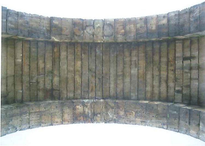
Detalle del intradós de la bóveda
