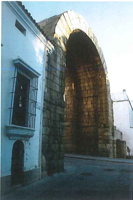
Vista lateral del arco desde Oeste.
