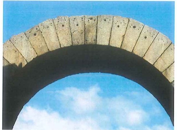
Detalle de las dovelas del arco y los orificios para la colocación de arquivolta de mármol.
